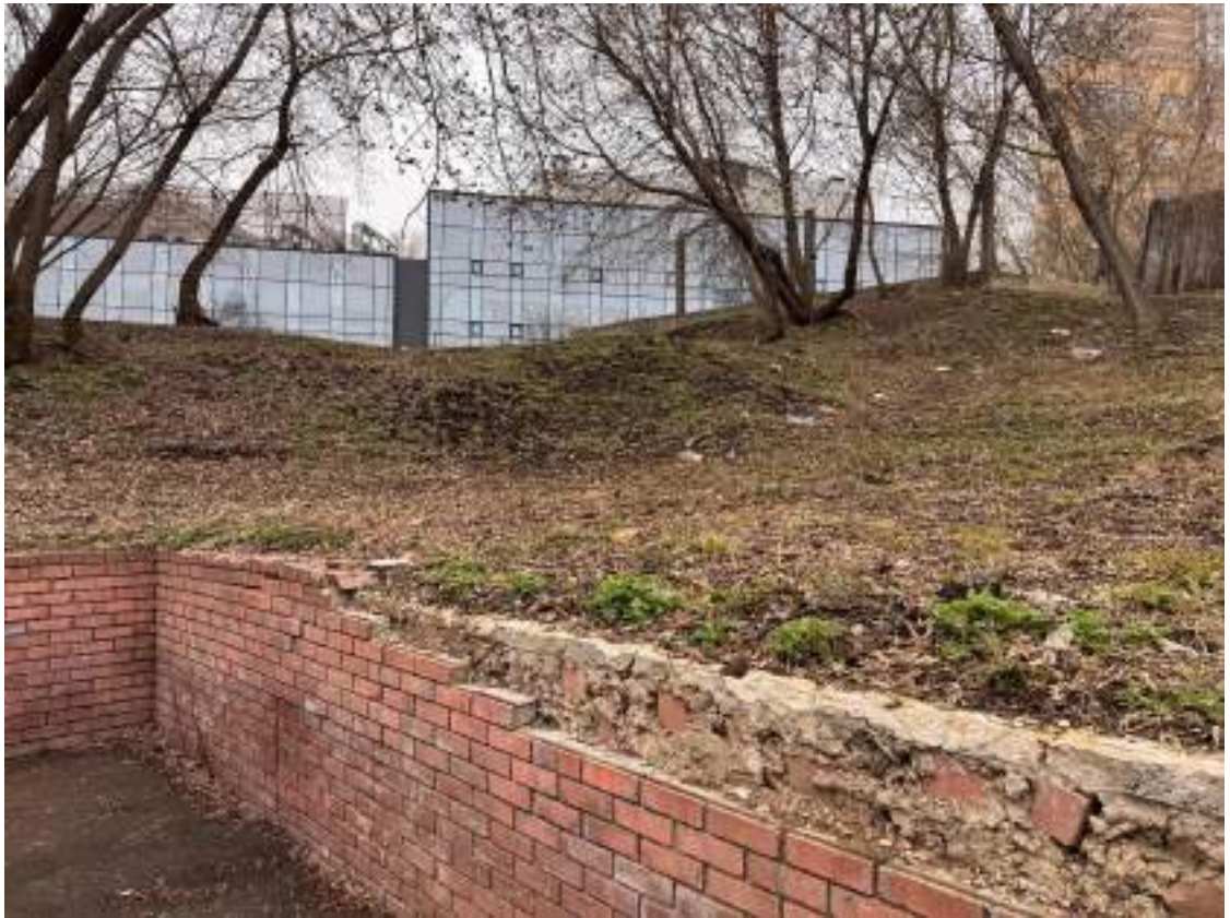
Т.Ф.39. Исследуемый земельный участок, вид с юга на подпорную стену
