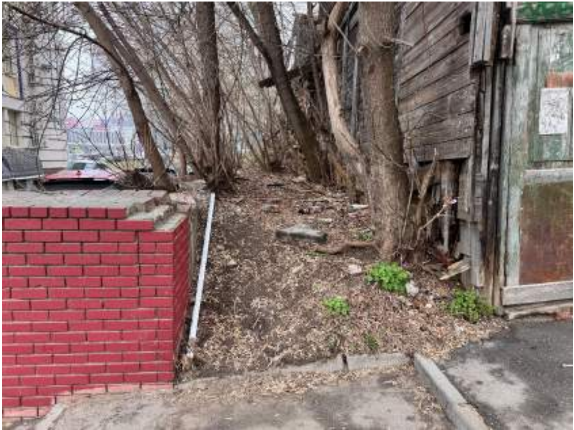
Т.Ф.11. Исследуемый земельный участок, фрагмент подпорной стены, вид с юго-востока, с нечетной стороны улицы Нестерова
