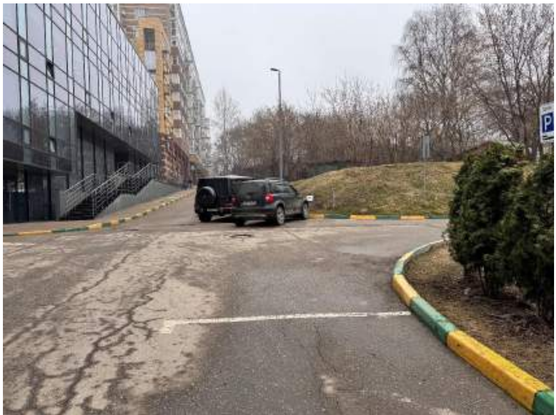
Т.Ф.26. Исследуемый земельный участок, вид с юго-запада, с парковки
