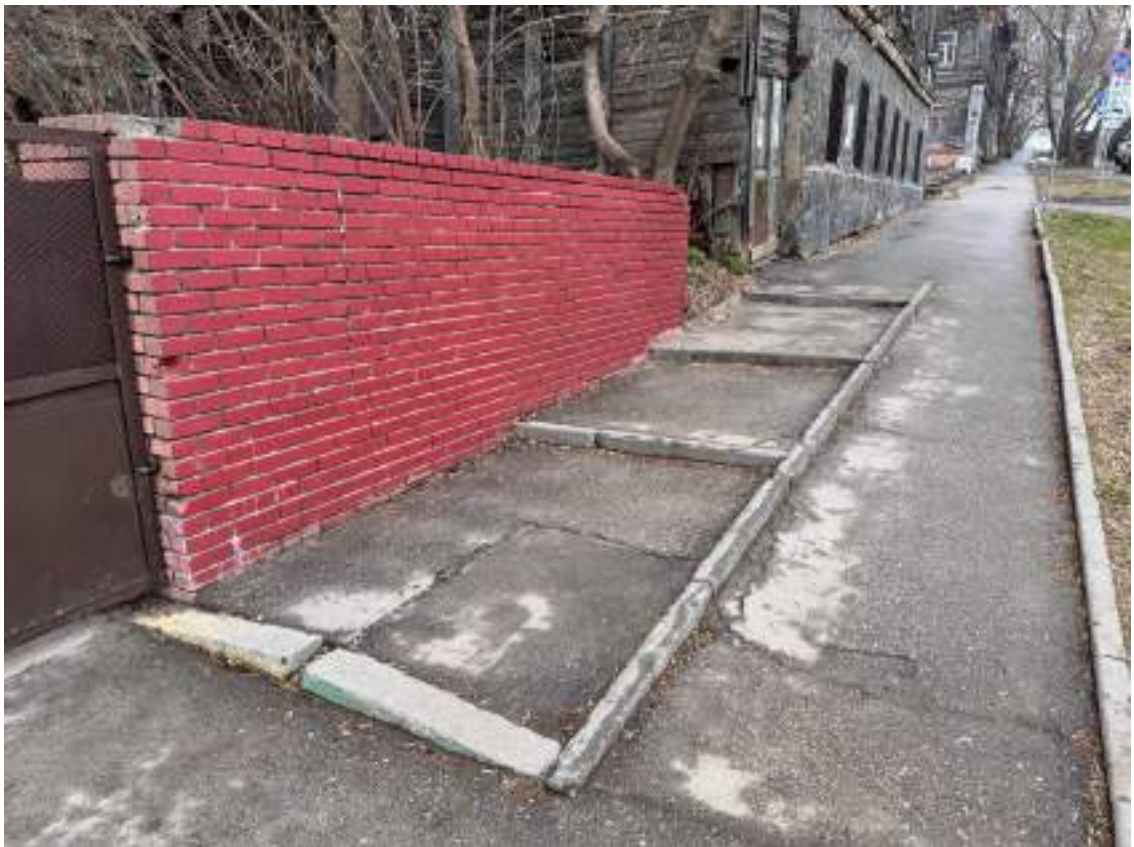
Т.Ф.10. Исследуемый земельный участок, подпорная стена, вид с юга, с нечетной стороны улицы Нестерова
